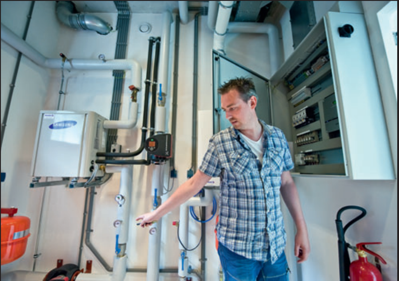
De DMS is een integraal onderdeel van de DVM-S-warmtepomp van Ambrava en is opgenomen in de regelkast van waaruit de complete installatie wordt aangestuurd.
